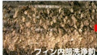
フィン内部洗浄前
